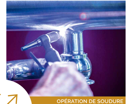
OPÉRATION DE SOUDURE
